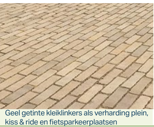
Geel getinte kleiklinkers als verharding plein, kiss & ride en fietsparkeerplaatsen
